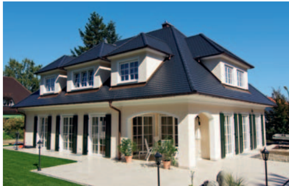
Traditionelle Biberschwanzeindeckung in trendigem Farbton „NUANCE“ schieferteron engobiert: Einfamilienhaus in Wertingen
